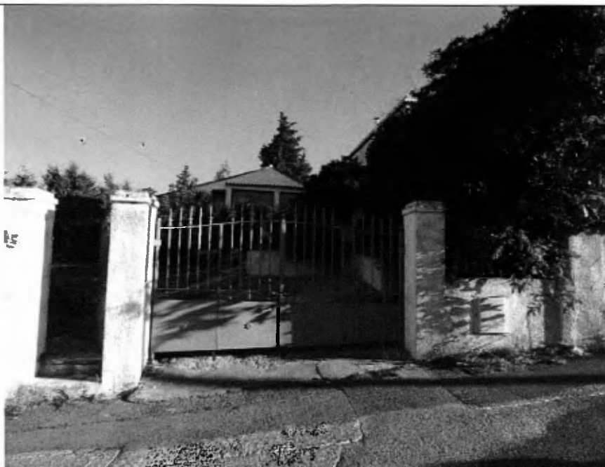
Le portail ouvre sur une aire de stationnement bitumé
