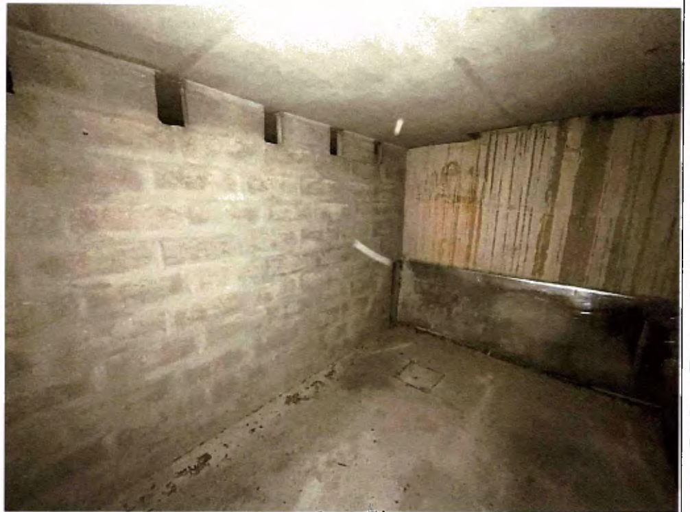
La poutre au-dessus de l'entrée est floquée.
