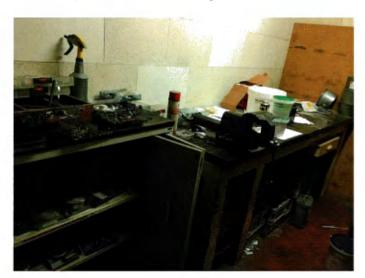
Les murs sont composés de panneaux en Siporex en bon état d'une part et d'un placage faïencé d'autre part.
