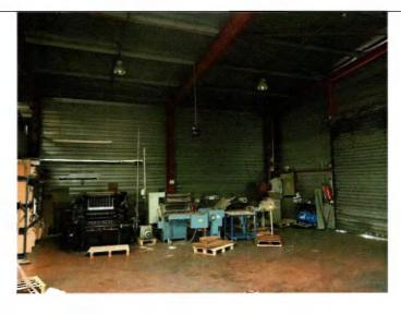
La structure de ce bâtiment est assurée par des poutres métalliques verticales et horizontales.
